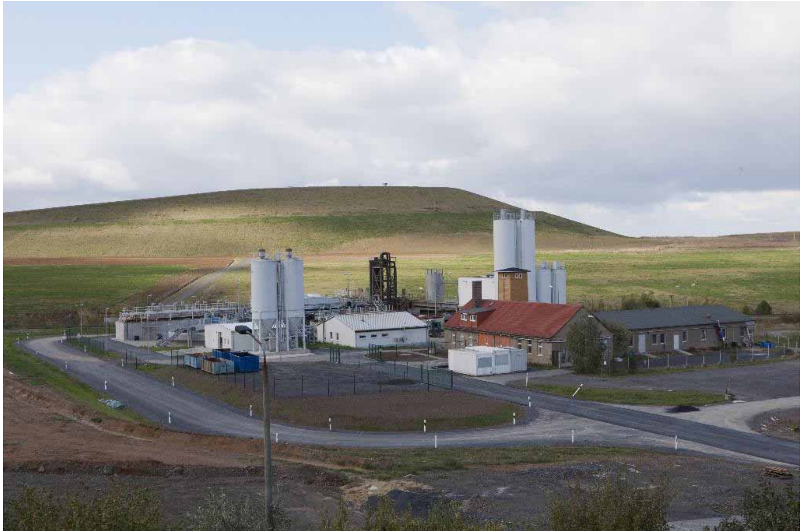
WBA Ronneburg mit Erweiterung – im Hintergrund der Aufschüttkörper des Tagebaus Lichtenberg (Oktober 2011)
