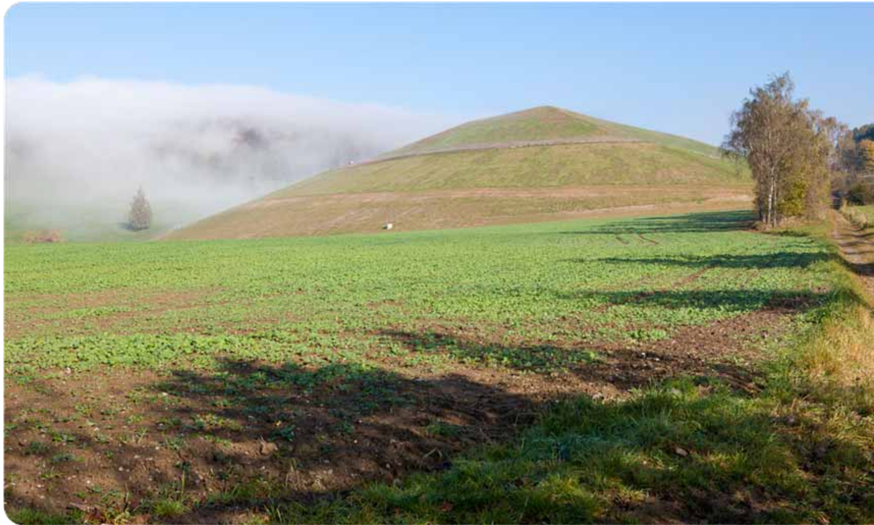
Halde 296 am Standort Schlema-Alberoda nach Abschluss der Sanierung
